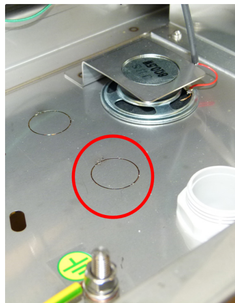
Figure 4 - L'ouverture pour le montage du câble UTP et son logement
