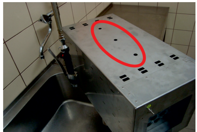
Photo 5 - ouvertures de service
