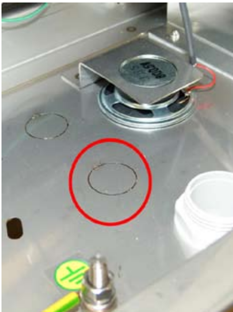
Bild 4: Öffnung zur Montage der Verschraubung das UTP Kabel
